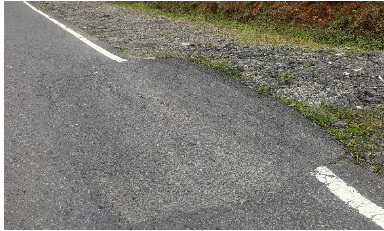
Gambar 1. 3 Tambalan ( patching ) pada STA 446+000
