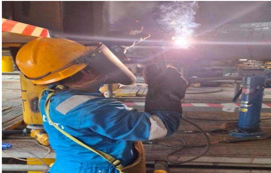
Gambar 2. 9 Pengelasan menggunakan SMAW
