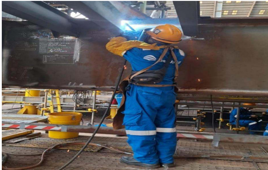
Gambar 2. 7 Pengelasan dengan FCAW
