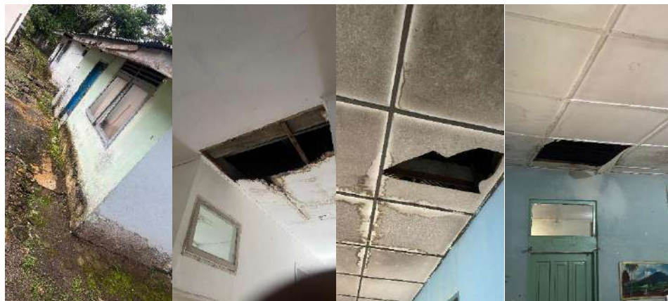
Gambar 1. 1 Kondisi Fisik Bangunan
