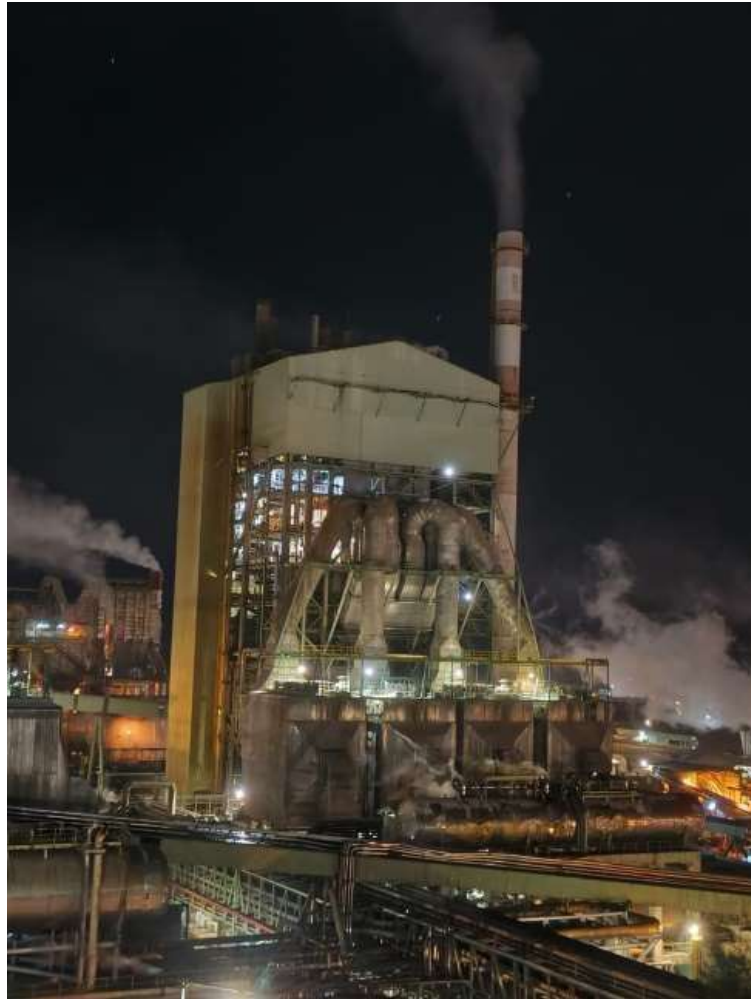
Gambar1.1. Boiler watertube di Pangkalan Kerinci
