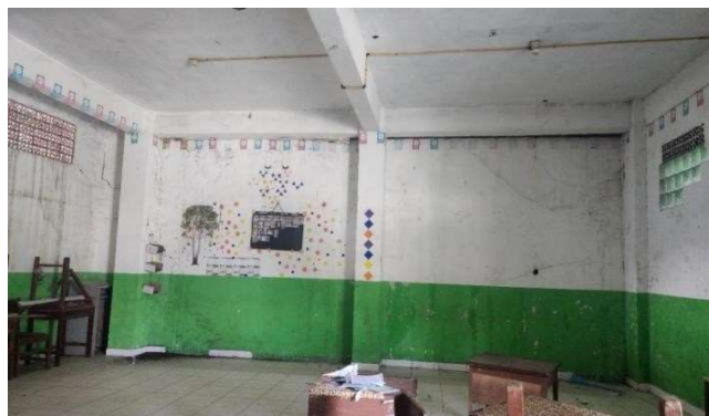
Gambar 1.1 Kondisi Bangunan SMP 3 Muhammadiyah Kota Padang
