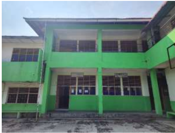
Gambar 1. 1 Kondisi salah satu bangunan Gedung Sekolah dikota Padang
