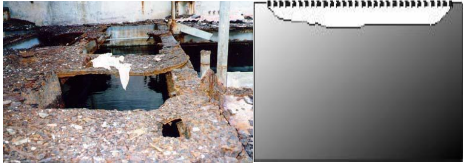
Gambar 2.12 Korosi Merata Pada Logam
