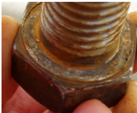
Gambar 2.6 Crevice Corrosion Pada Baut
