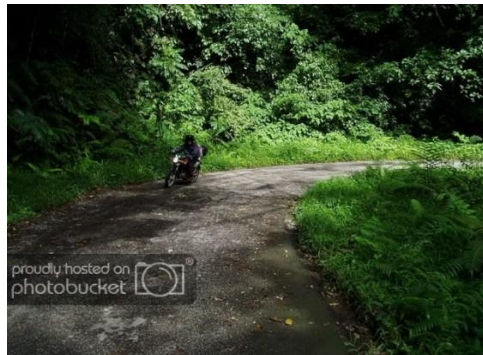
Gambar 4. Segmen Tikungan Ruas Jalan Tapan – Sungai Penuh Tidak dilengkapi Rambu Peringatan Tikungan dan Marka Jalan.
