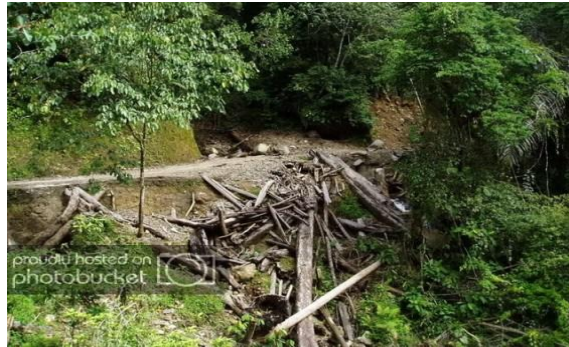
Gambar 3. Segmen Ruas Jalan Tapan – Sungai Penuh Tidak dilengkapi Tembok Penahan Tanah.
