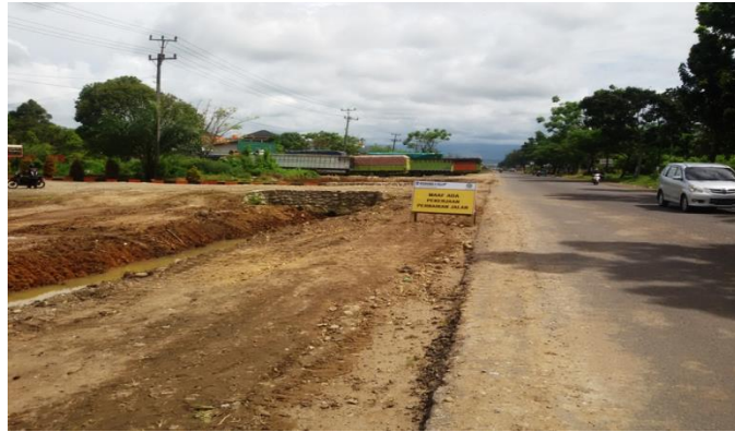
Gambar 2. Salah Satu Segmen Ruas Jalan ByPass Kota Padang Sedang Dalam Pengerjaan Tahap Pembangunan Pelebaran.
