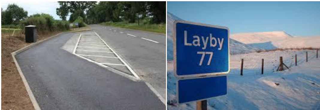
Gambar 4. Titik Pemberhentian Angkutan Umum di Luar Badan Jalan/Lajur Lalu-Lintas ( Layby ).
