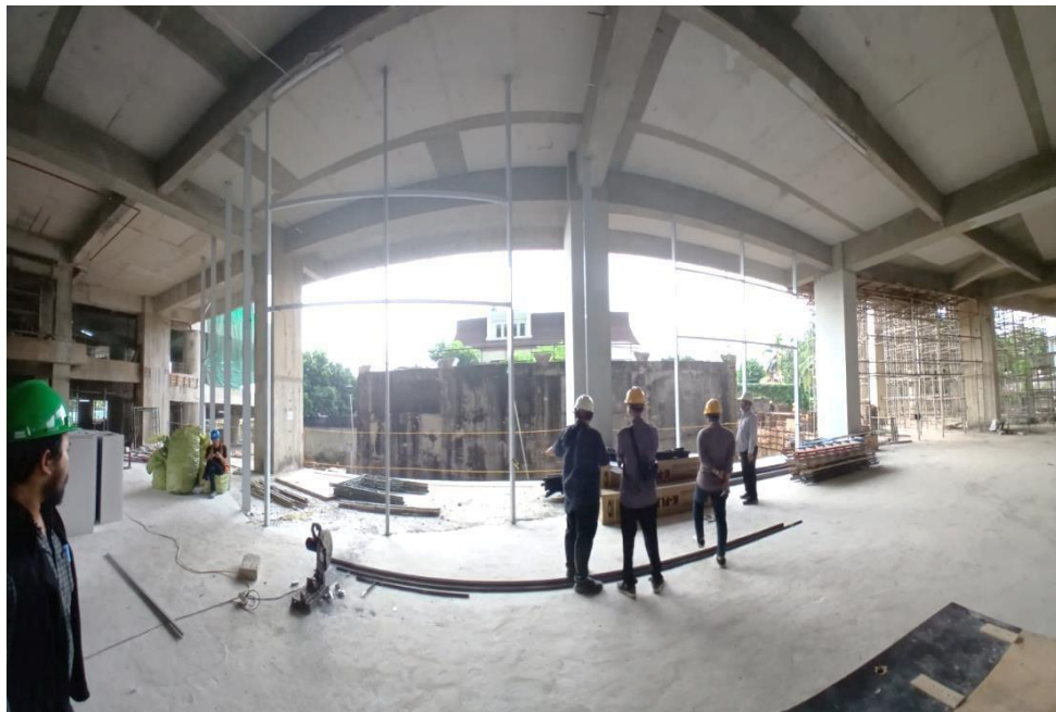
Gambar 3. 14 Pengecekan progres pekerjaan dinding partisi
