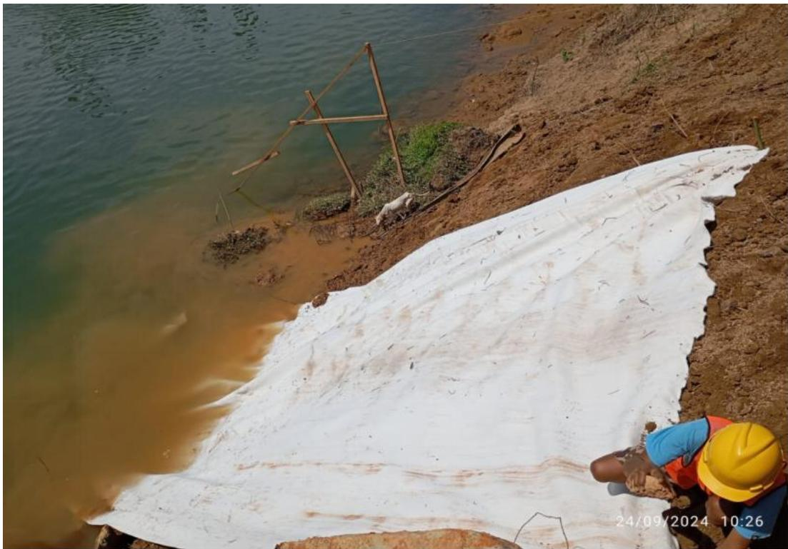
Gambar 4.9. Pemasangan Geotextile a
