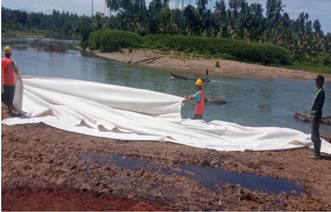
Gambar 4.6. Penghambaran Geotextile
