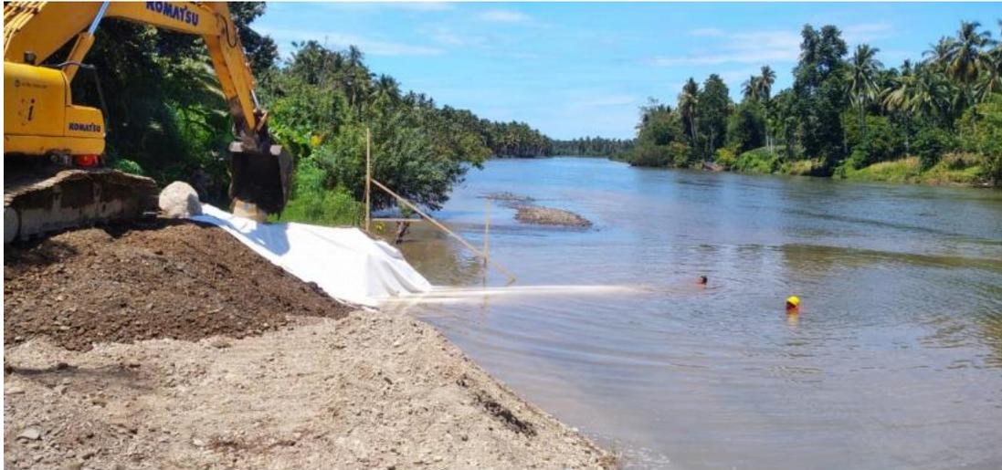
Gambar 4.10. Pemasangan Geotexstile b
