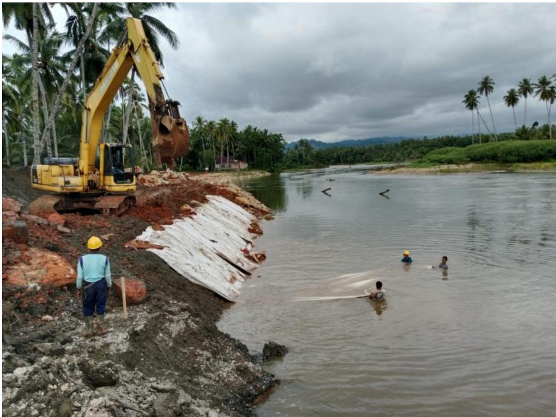
Gambar 4.12. Pemasangan Geotexstile c
