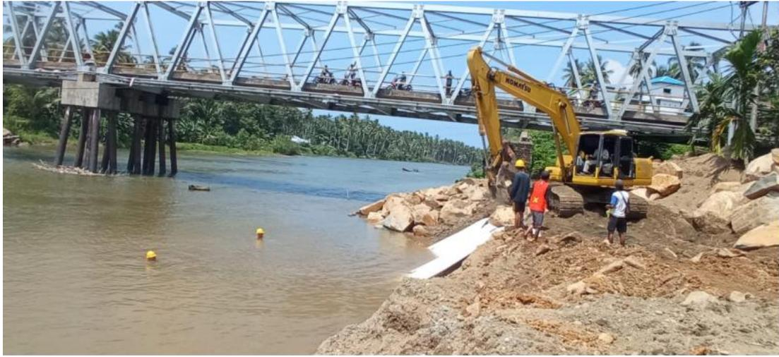
Gambar 4.13. Pemasangan Geotexstile d
