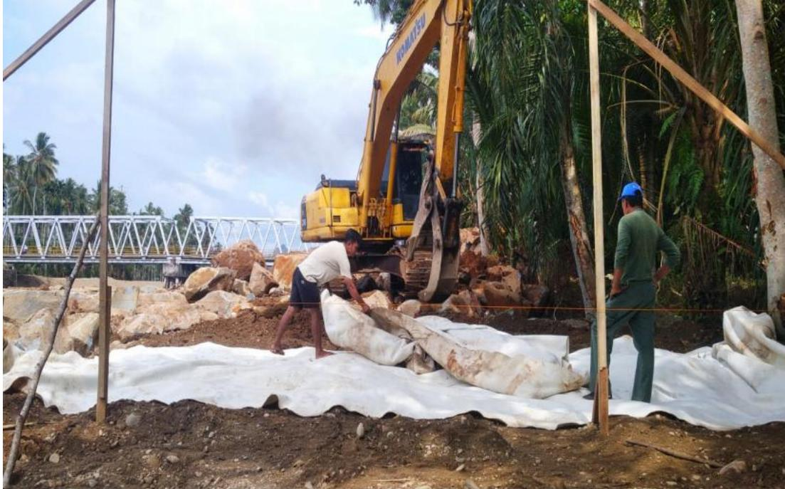
Gambar 4.7. Pengukuran Geotextile
