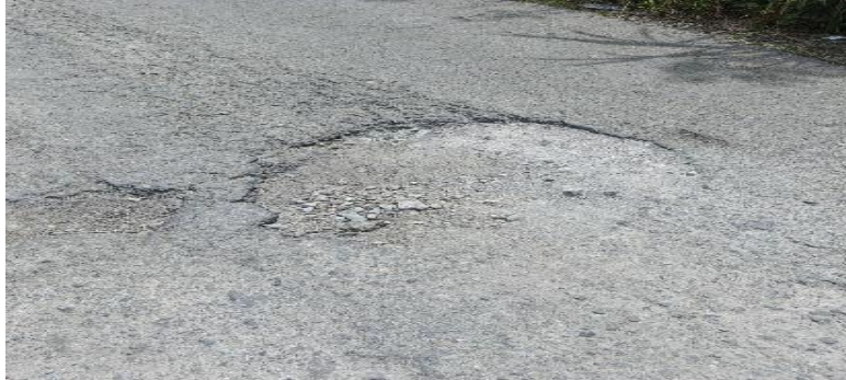
Gambar 1. 1Lubang Di STA 385+000
