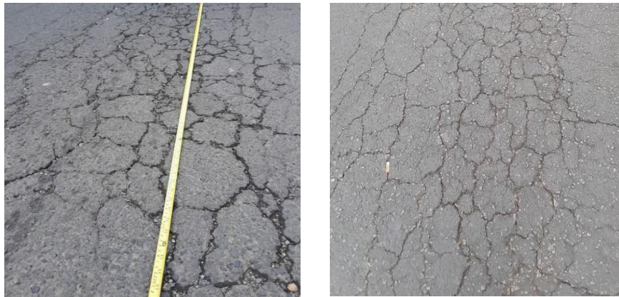
Gambar 1. 2 Retak kulit buaya
